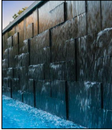
تشكيل الشلال الحائطي بتشطيب مادة الجرانيت في ميدان Nero Notte في مدريد-اسبانيا. المصدر: موقع الكتروني graniteworks.com
